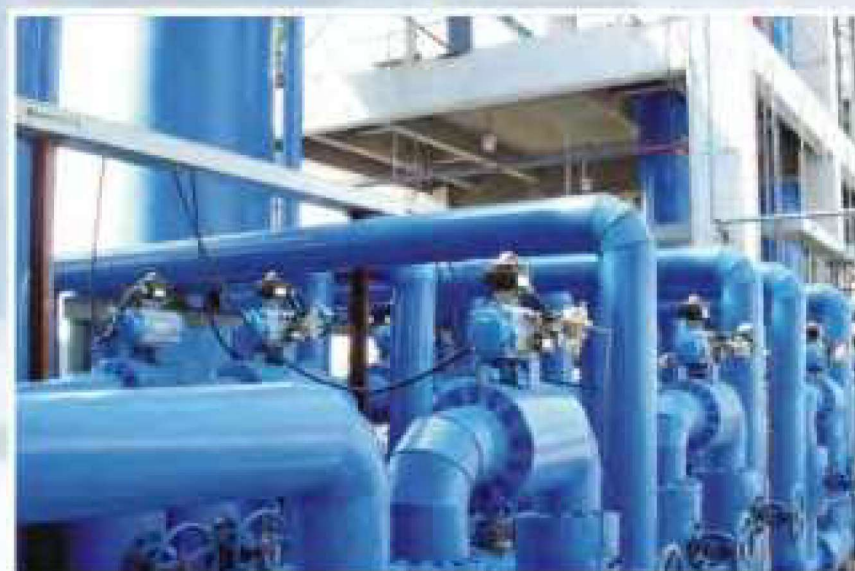
球阀使用在多晶硅生产装置
