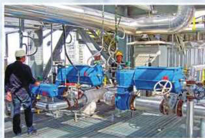
气动球阀使用在石化装置
