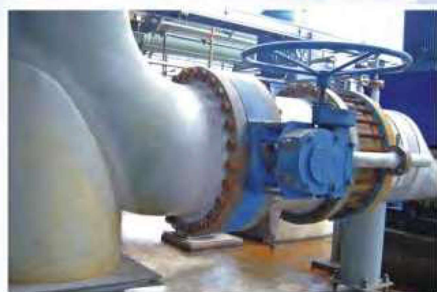
高性能蝶阀使用在化工装置
