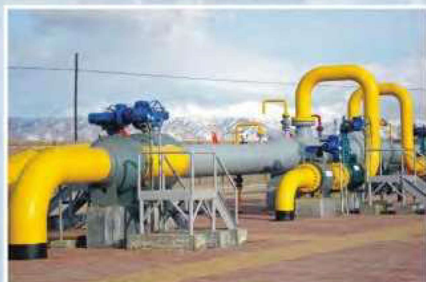
全焊接管线球阀使用在天然气管线
