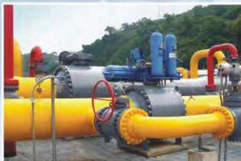
管线球阀使用在天然气管线
